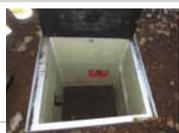
La Chambre de tirage composite est utilisée pour connecter les câbles ou les tubes dans les nouvelles installations ou en rénovation. Cette chambre se compose de divers éléments montables à souhait.
