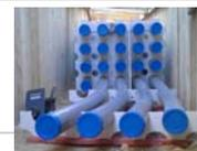
Les dispositifs sont utilisés pour assurer le positionnement des fourreaux et leurs espacement relatif. Ils sont principalement employés pour les ouvrages fourreaux PVC béton ou fourreaux PEHD.
